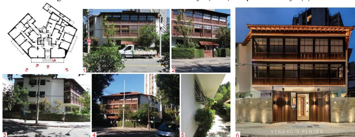
Figura 1. Edifício Rosita Sá antes do retrofit (1 a 5) e depois do retrofit (6)
