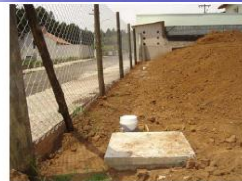
Figura 5 – Trincheira após recobrimento com terra e detalhe dos postos de monitoramento.
