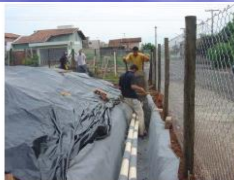
Figura 3 – Revestimento da trincheira com geotêxtil e preenchimento com brita.
