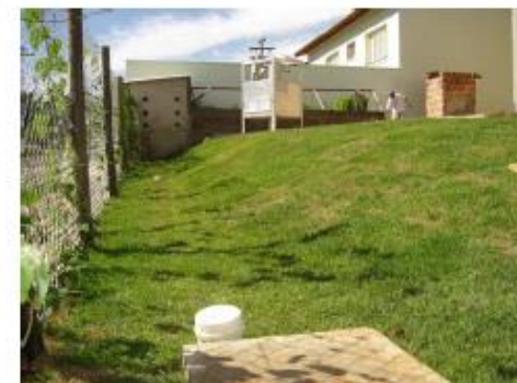
Figura 6 – Disposição final da trincheira no terreno.
