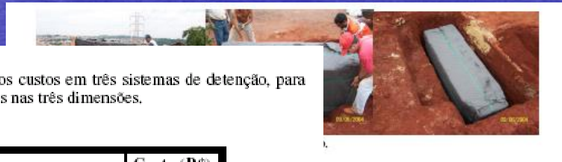
Foto 02 - Engradados revestidos com geotêxtil.
