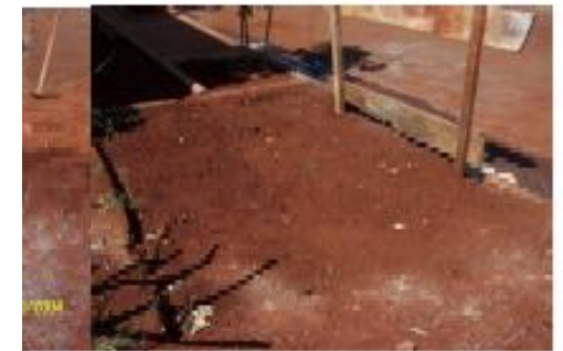
rio ao sistema de água pluvial e reaterro do local
