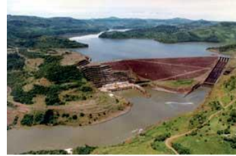
Construção de GBM
