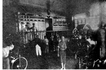
Usina térmica 52kW, RJ
