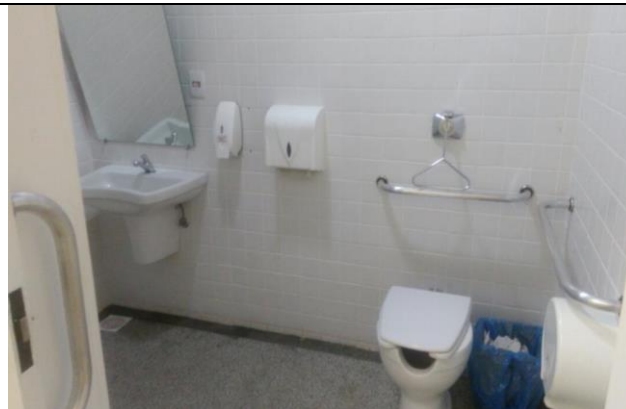
f) Papeleira disposta a 0,90 m de altura; Acessórios em conformidade com a norma.
