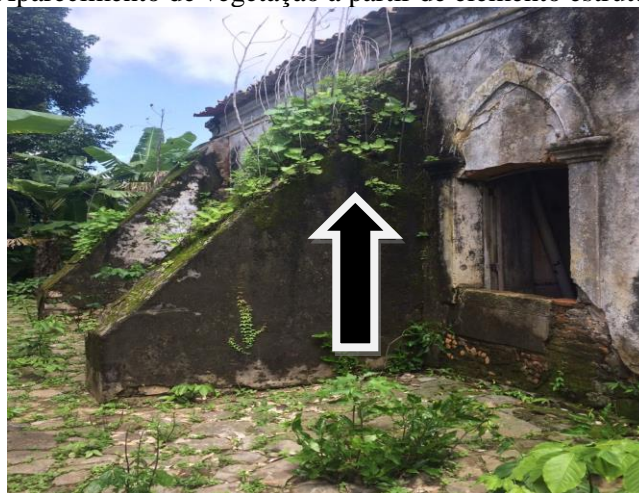
Figura 7: Aparecimento de vegetação a partir de elemento estrutural externo
