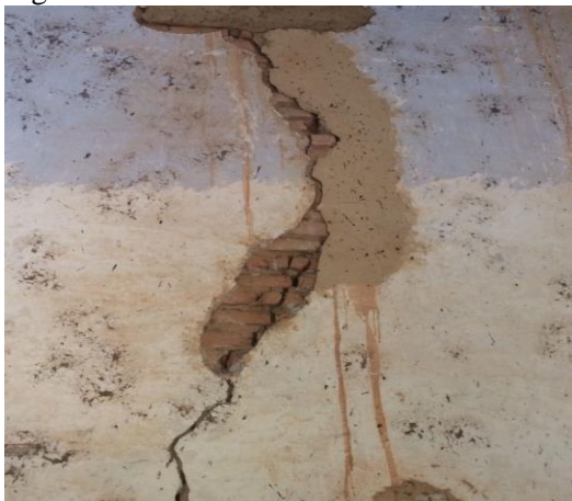
Figura 1: Trinca interna
