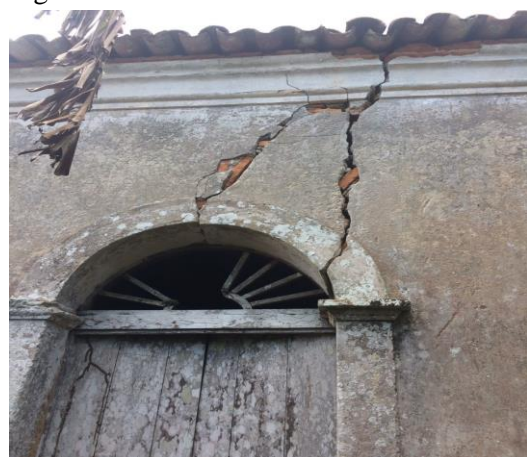
Figura 2: Trinca externa
