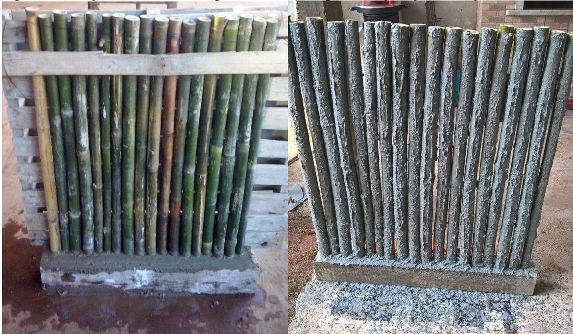
Figura 01: Fixação dos bambus na viga baldrame, conseguinte, a aplicação do chapisco.
