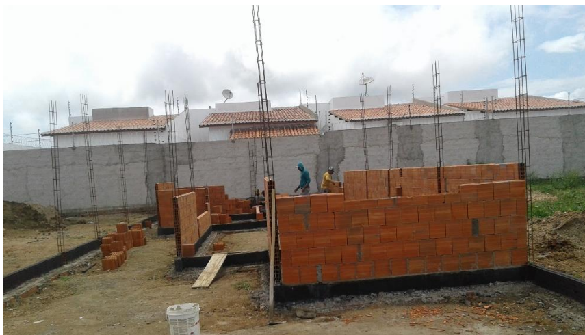
Figura 4. Obra com tijolo de encaixe em Sobral, Ceará.
