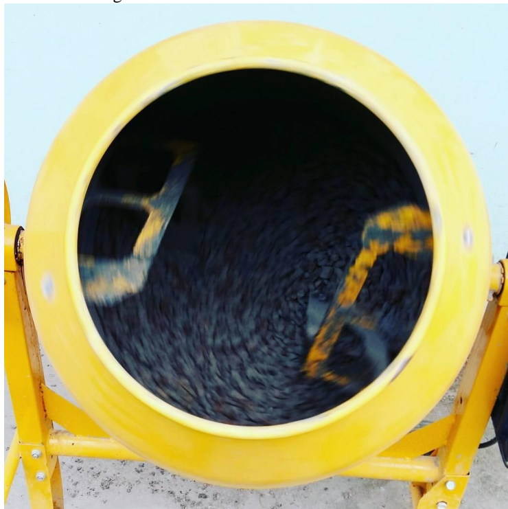
Figura 2 – Mistura dos materiais na betoneira.
