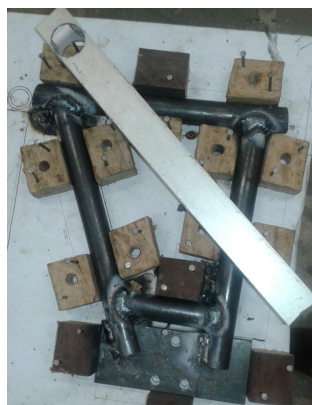
Figura 2. Braço da suspensão dianteira e a utilização de gabarito na execução da solda.
