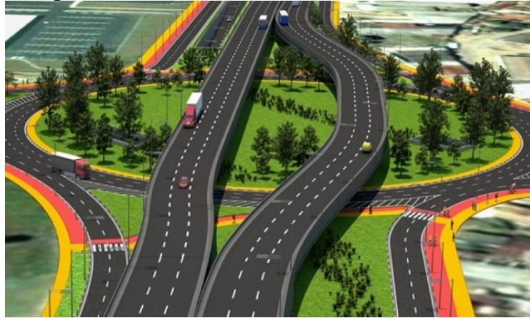
Figura 4. Viaduto da antiga Policia Rodoviária Federal ( PRF)
