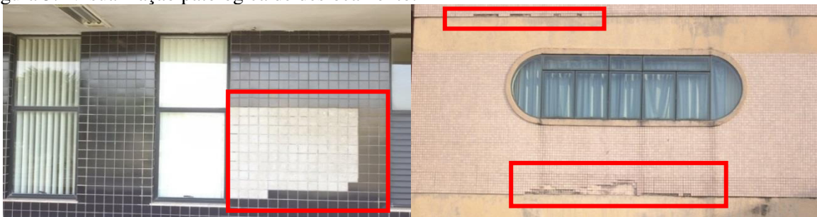
Figura 3. Visualização patológica de deslocamento.
