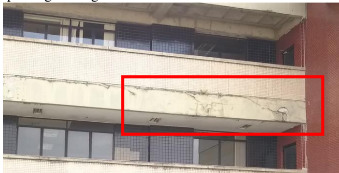
Figura 7. Visualização patológica de gretamento.
