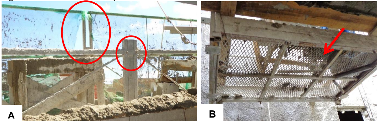
Figura 3. Piso de andaime suspenso utilizado na obra analisada
