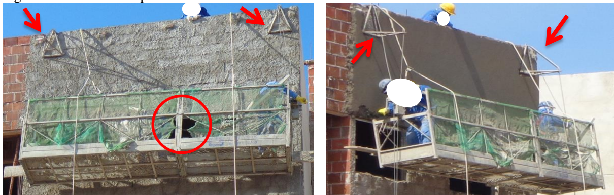
Figura 1. Andaime suspenso utilizado na obra analisada
