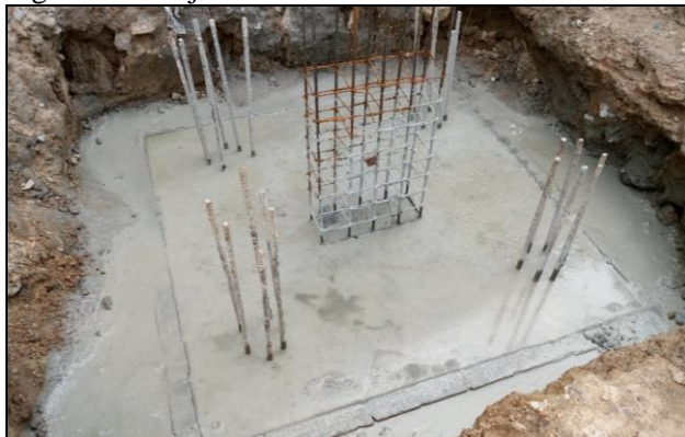
Figura 02. Projeto de estacas raiz no centro de Caxias – MA.
