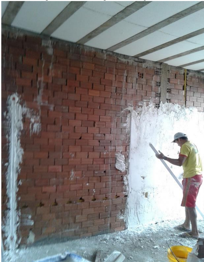
Figura 1. Reboco de gesso sendo aplicado.
