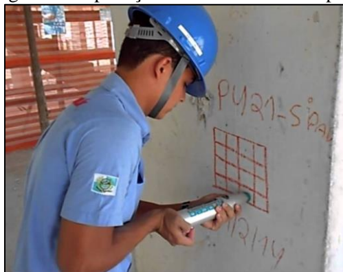
Figura 1 – Aplicação do esclerômetro no pilar
