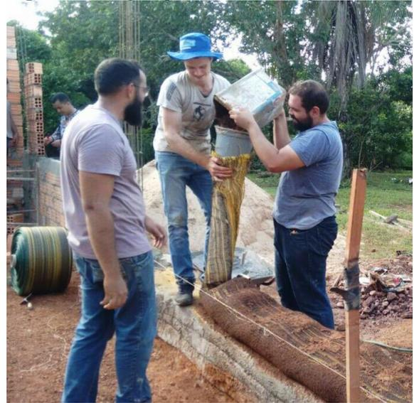
A mistura do solo úmido com o cimento é posta em um funil revestido pelo raschel distribuindo o segmento desta parede. A própria fundação é nivelada pela compactação da primeira camada, tendo o auxílio de linha de náilon como orientação locadas nas laterais. Por sua vez, a compactação é realizada em todas as superfícies do hiperadobe, isto para que a mistura seja consolidada adquirindo uniformidade.
