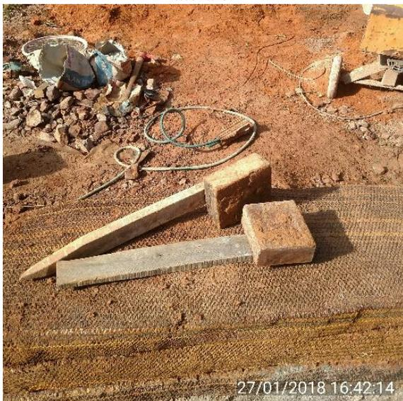
Figura 7 – Parte do processo de compactação manual.
