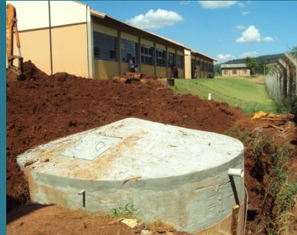
Centro de Artesanato em construção
