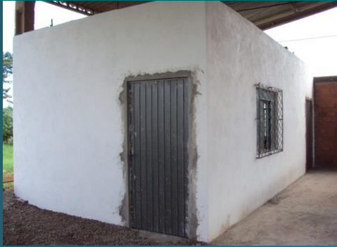
Almoxarifado e cisterna
