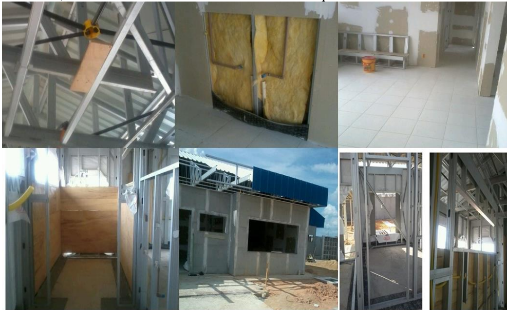
Figura 2. Reforço de luminárias, isolamento termo acústico, acabamentos e piso, reforço em áreas molhadas, revestimento de fachadas e abertura de esquadrias na estrutura
