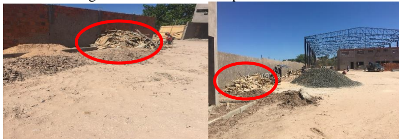
Figura 5 e 6 - Madeiras espalhadas na obra
