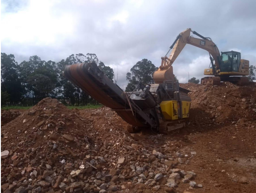
Figura 1. Trituração de entulho na Unidade de Recebimento de Entulho - URE
