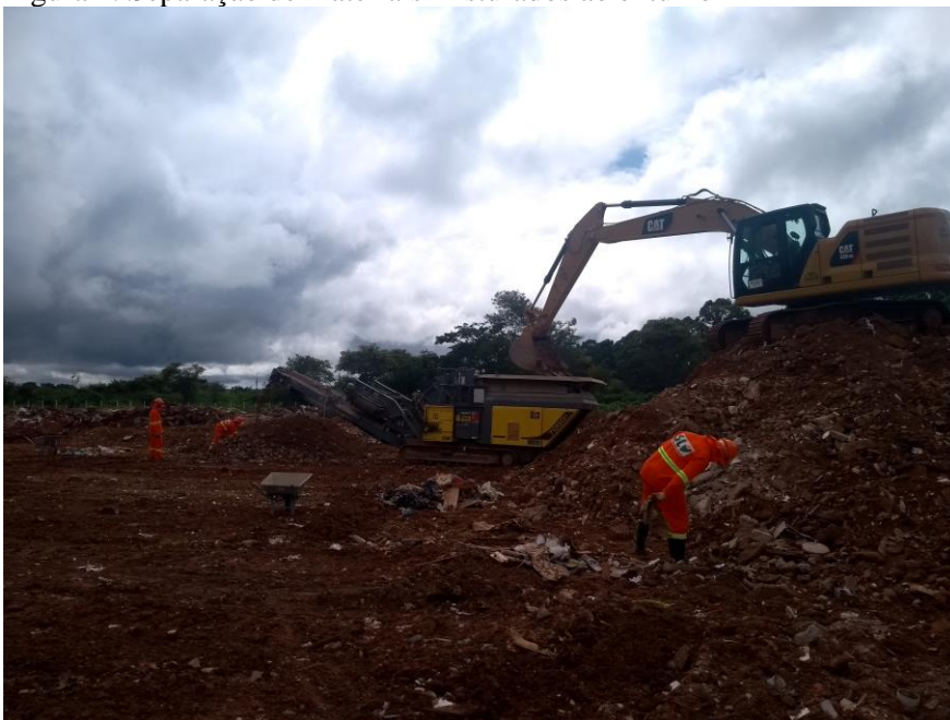
Figura 2. Separação de materiais misturados ao entulho
