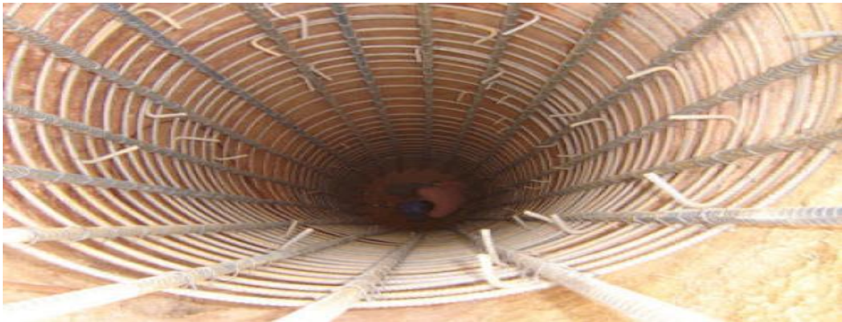
Figura 2 – Trabalhador executando escavação de Tubulão encamisado.
