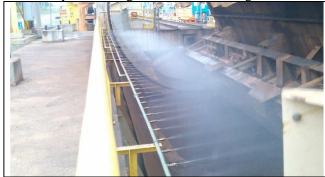
Figura 6 – Teste do sistema de aspersão de água no virador de vagões
