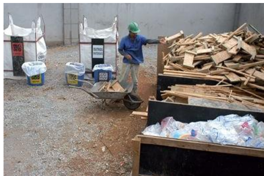
Figura 6. Alternativa de acondicionamento de resíduos em big bags e baias (SAURIN;FORMOSO, 2006).
