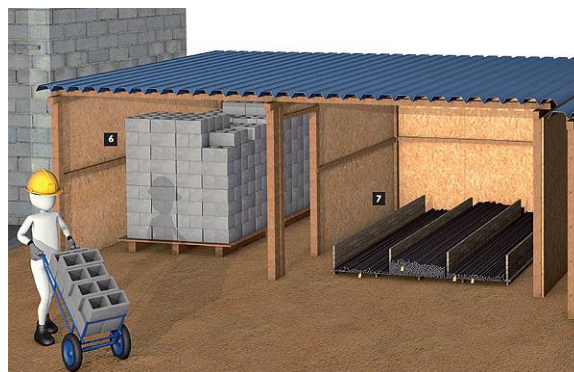
Figura 5. Armazenamento dos blocos sobre paletes em estrutura coberta (SAURIN;FORMOSO, 2006).
