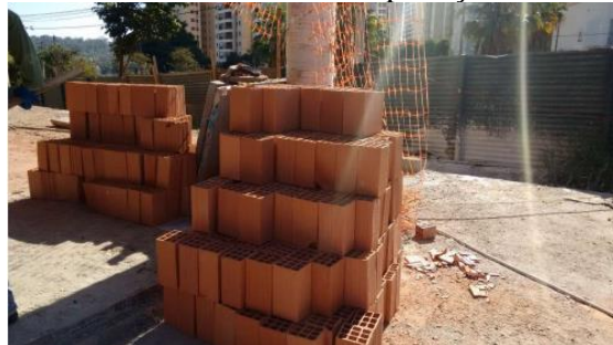
Figura 1. Disposição dos blocos cerâmicos sem a devida proteção. Fonte: Autoria própria.
