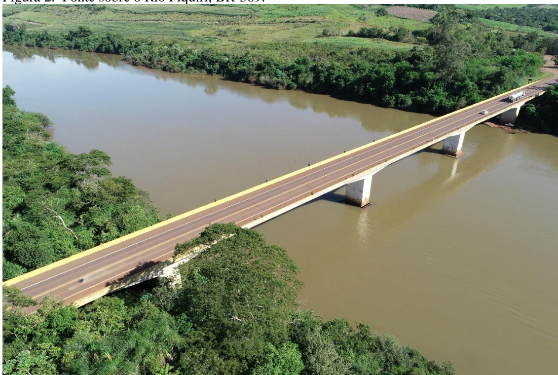
Figura 2. Ponte sobre o Rio Piquiri, BR-369.
