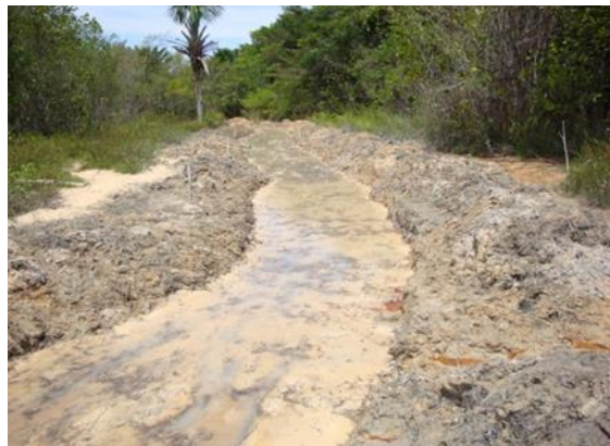
Foto 2 - Medida de controle do processo erosivo
