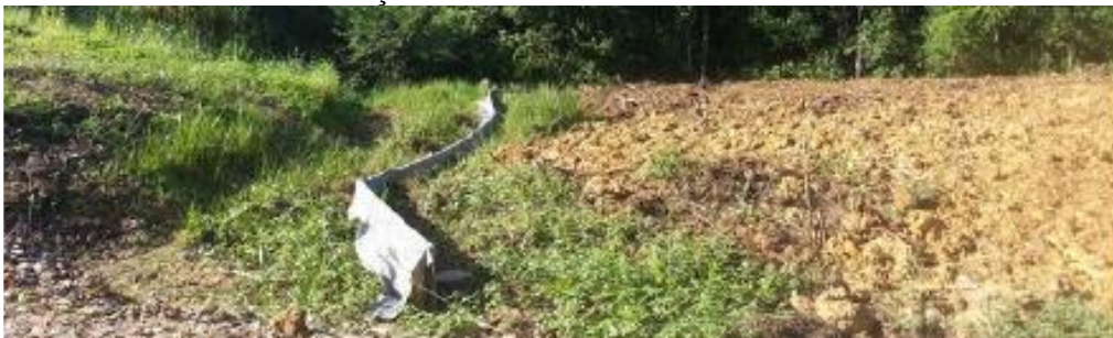
Figura 3. Foto da Barreira de Contenção Instalada.
