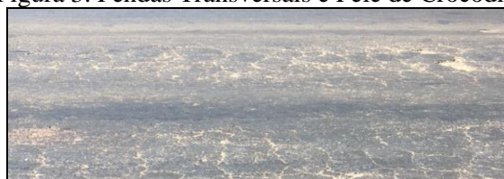
Figura 3. Fendas Transversais e Pele de Crocodilo
